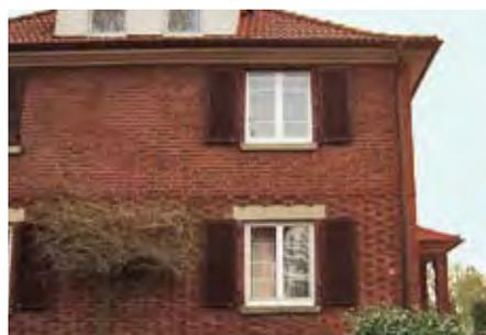
Abb. 8: Backsteinfassade mit sichtbarem Fenstersturz aus Beton
