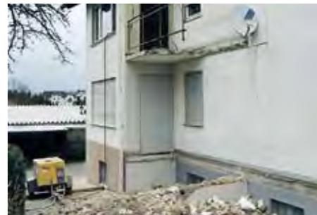
Abb. 55: Abbruch von Stahlbetonplatten zur Wärmebrückenvermeidung
