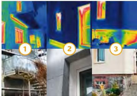
Abb. 56: Foto- und Thermographieaufnahmen von massiven Wärmebrücken bei einer Gebäudesanierung: dämmstoffdurchstoßende Balkonplatte (1); ungedämmte Fenster- und Türschwelle (2); ungedämmter Sockel aus Bruchsteinmauerwerk (3).
