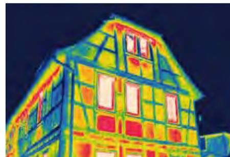
Abb. 22: Thermographieaufnahme eines Fachwerkhäuses. Das erkennbare Fachwerk wird bei der U-Wert-Berechnung flächenanteilig berücksichtigt.
